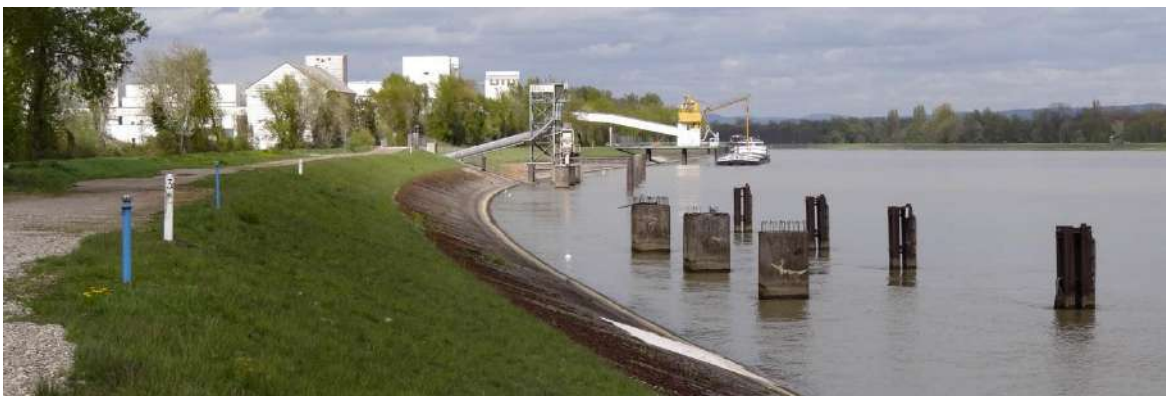
Centrale électrique sur la bande rhénane Source : Atlas des paysages Alsace
