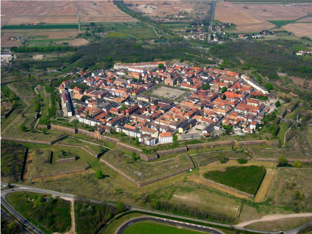
Fortification de Vauban à Neuf-Brisach Source : Wikipedia
